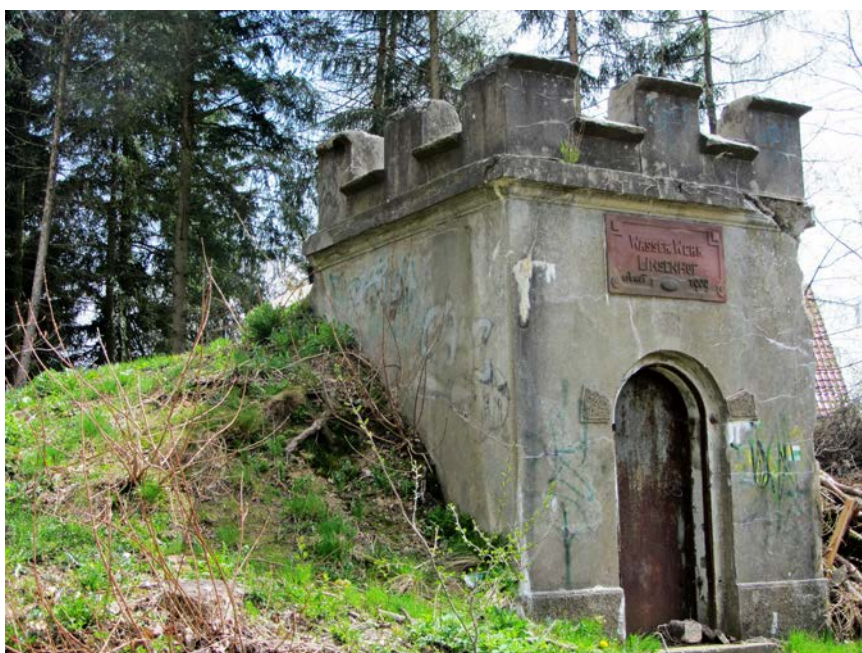
Wasserwerk Linsenhof (Stadtkreis Suhl, Thüringen)
