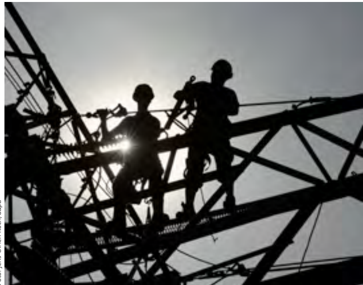
Techniker arbeiten an einem Strommast
